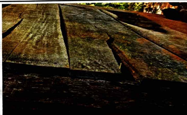
FOTO 4: Seguimiento el cambio de paredes
