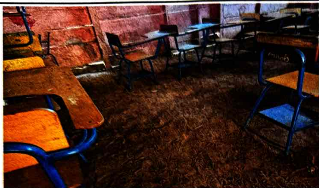
FOTO 1: Cambio de piso
